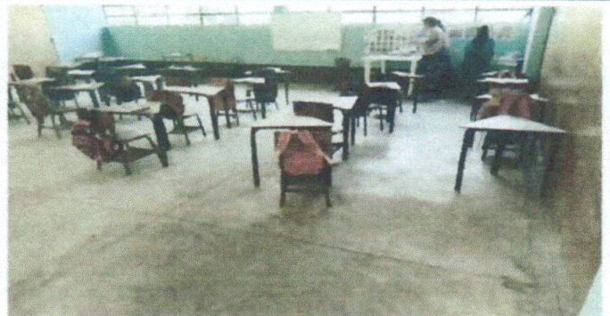
Foto 10: Sustitución de piso alisado a piso azulejo salon 3
