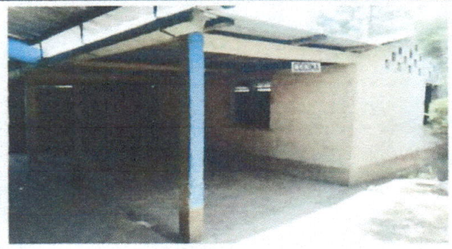
Foto 2: dotación de 4 ventanas de metal para la cocina
