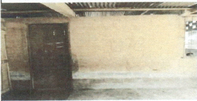
Foto 3: Cambio de puerta de madera por una puerta de metal para la cocina.
