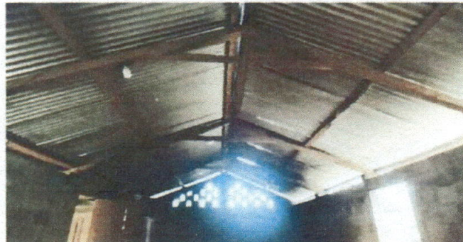
Foto 14: Cambio de lámina acanalada a troquelada.
