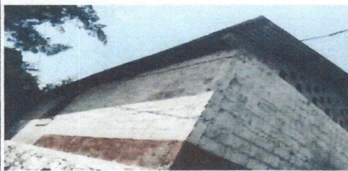
Foto 17: Colocación de canales de metal, atrás de la cocina
