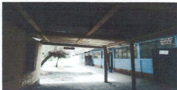
Foto 16: Cambio de láminas acanaladas a troqueladas corredor de la cocina.
