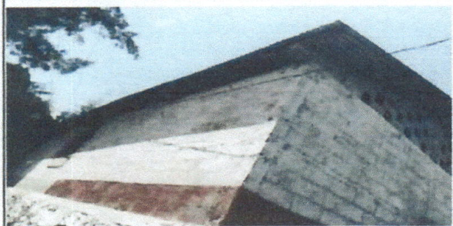
Foto 5: Repello parte exterior de la cocina.
