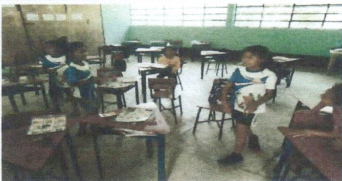
Foto 9: Sustitución de piso alisado a piso azulejo salon 2
