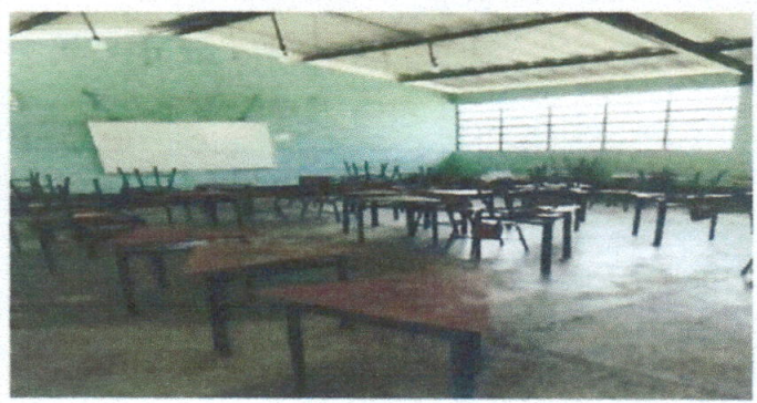
Foto 8: Sustitución de piso alisado a piso azulejo salon 1
